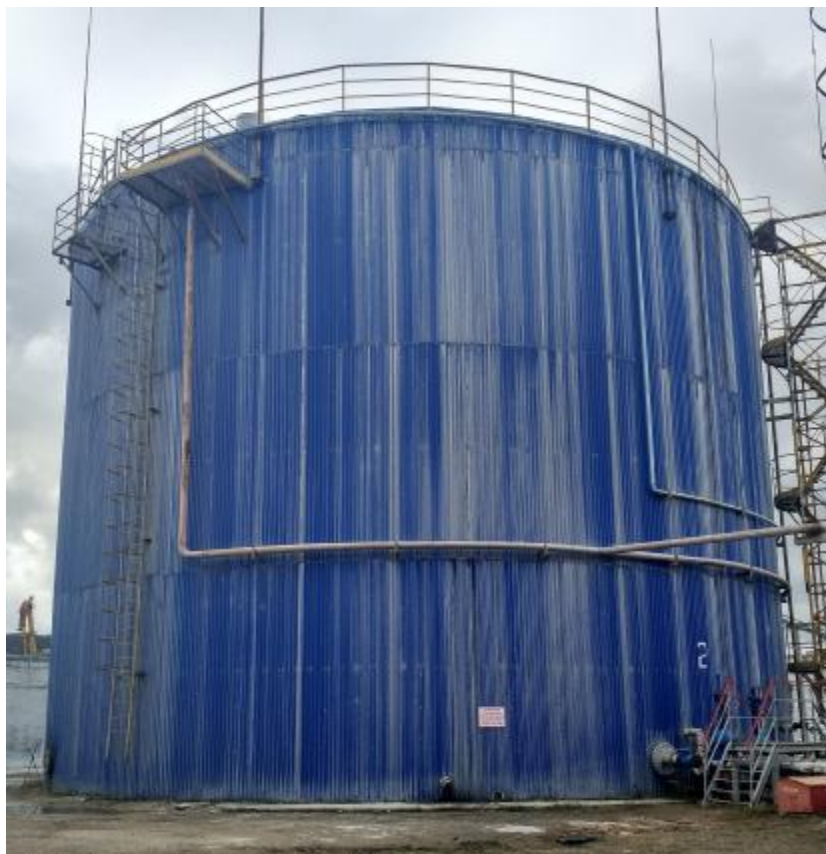
Рисунок 1 – Общий вид резервуаров стальных вертикальных цилиндрических РВС-5000
