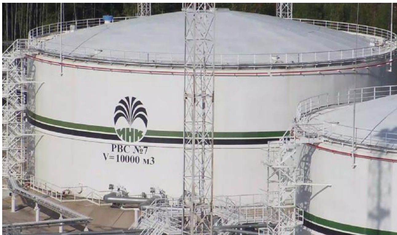
Рисунок 1 – Общий вид резервуара РВС-10000
