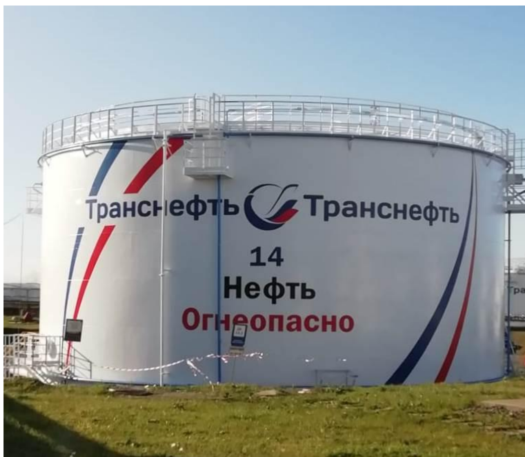
Рисунок 3 – Общий вид резервуара РВСП- 5000 зав.№ 14
