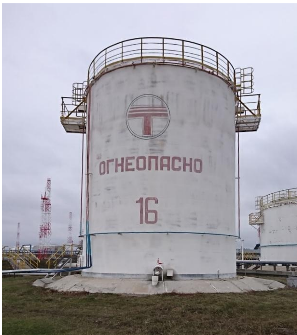
Рисунок 1 – Общий вид резервуара РВСП-1000 зав.№ 16
