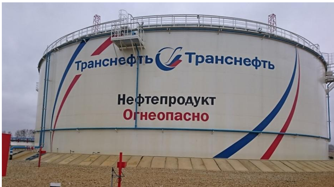
Рисунок 5 – Общий вид резервуаров РВ-20000 зав.№№ 105, 118
