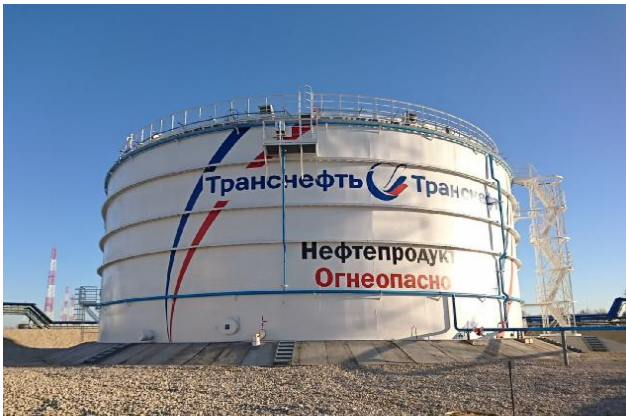
Рисунок 4 – Общий вид резервуаров РВСП-10000 зав.№№ 102, 104
