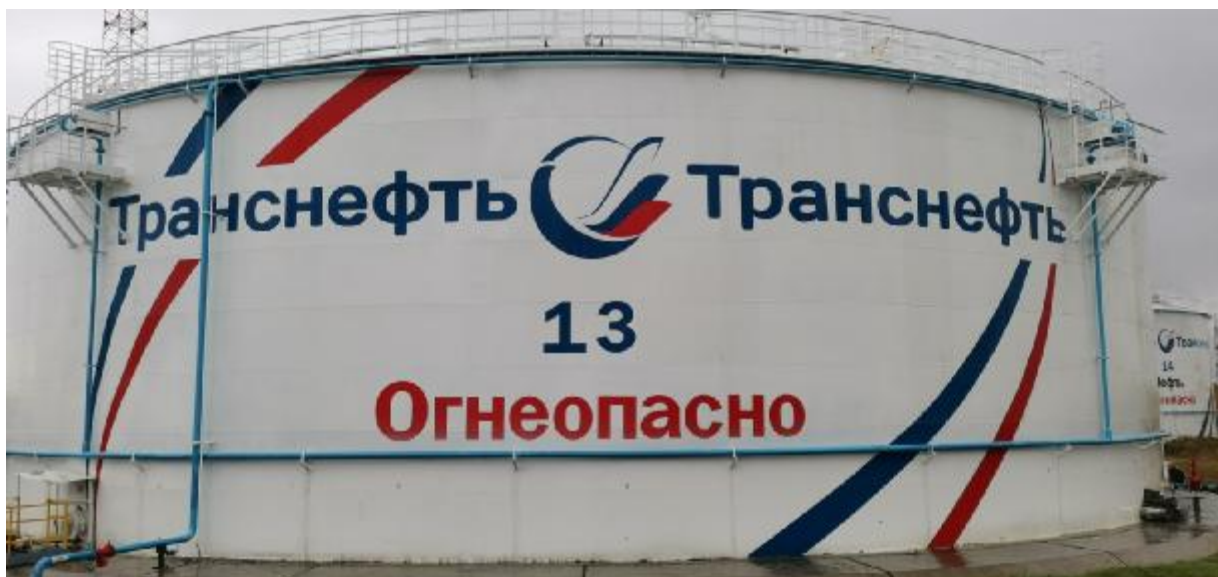
Рисунок 1 – Общий вид резервуара РВСП-20000 зав.№ 13
