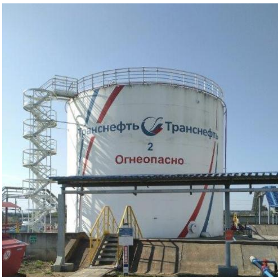
Рисунок 1 – Общий вид резервуара РВС-2000 зав.№ 2
