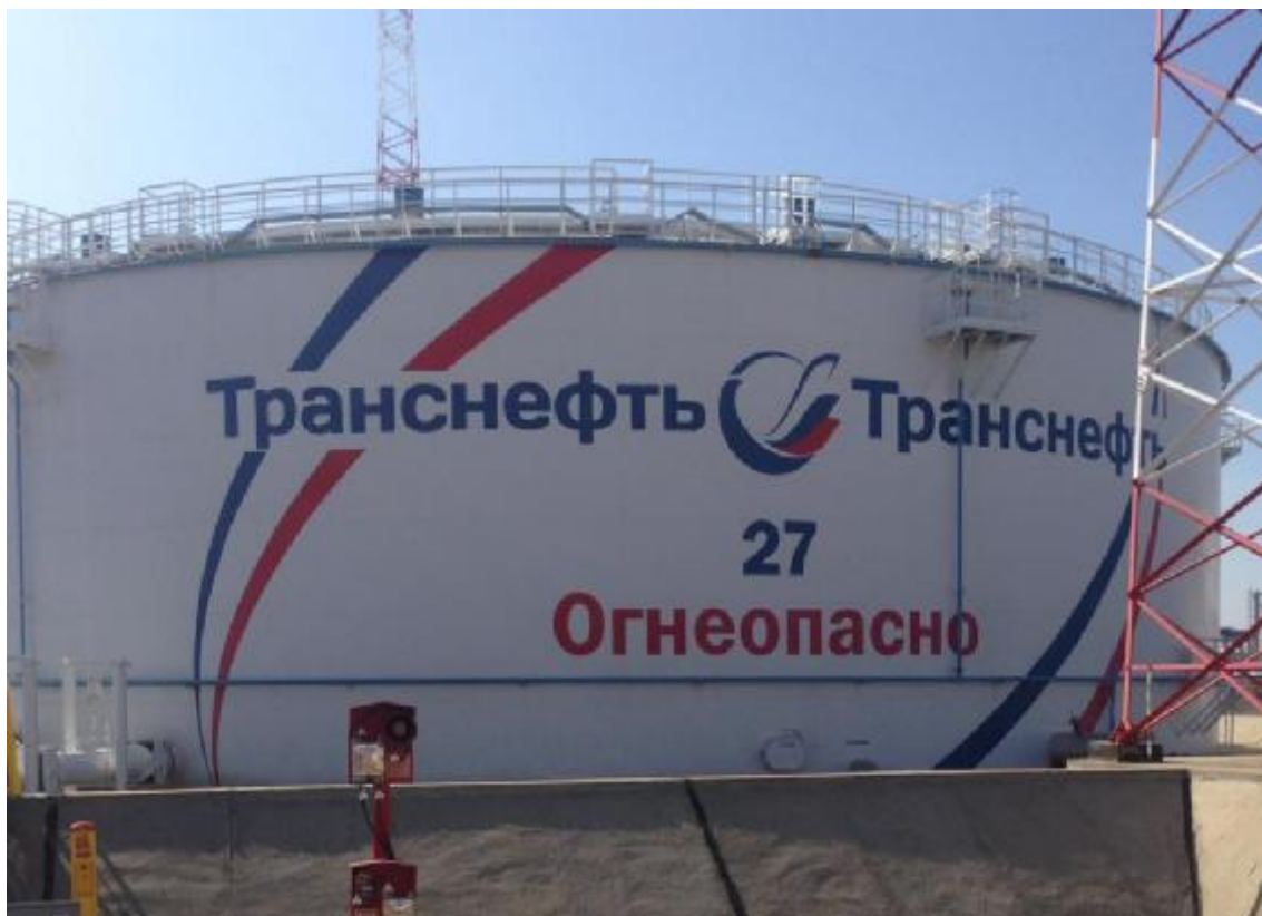
Рисунок 3 – Общий вид резервуара РВСП-20000 зав.№ 27
