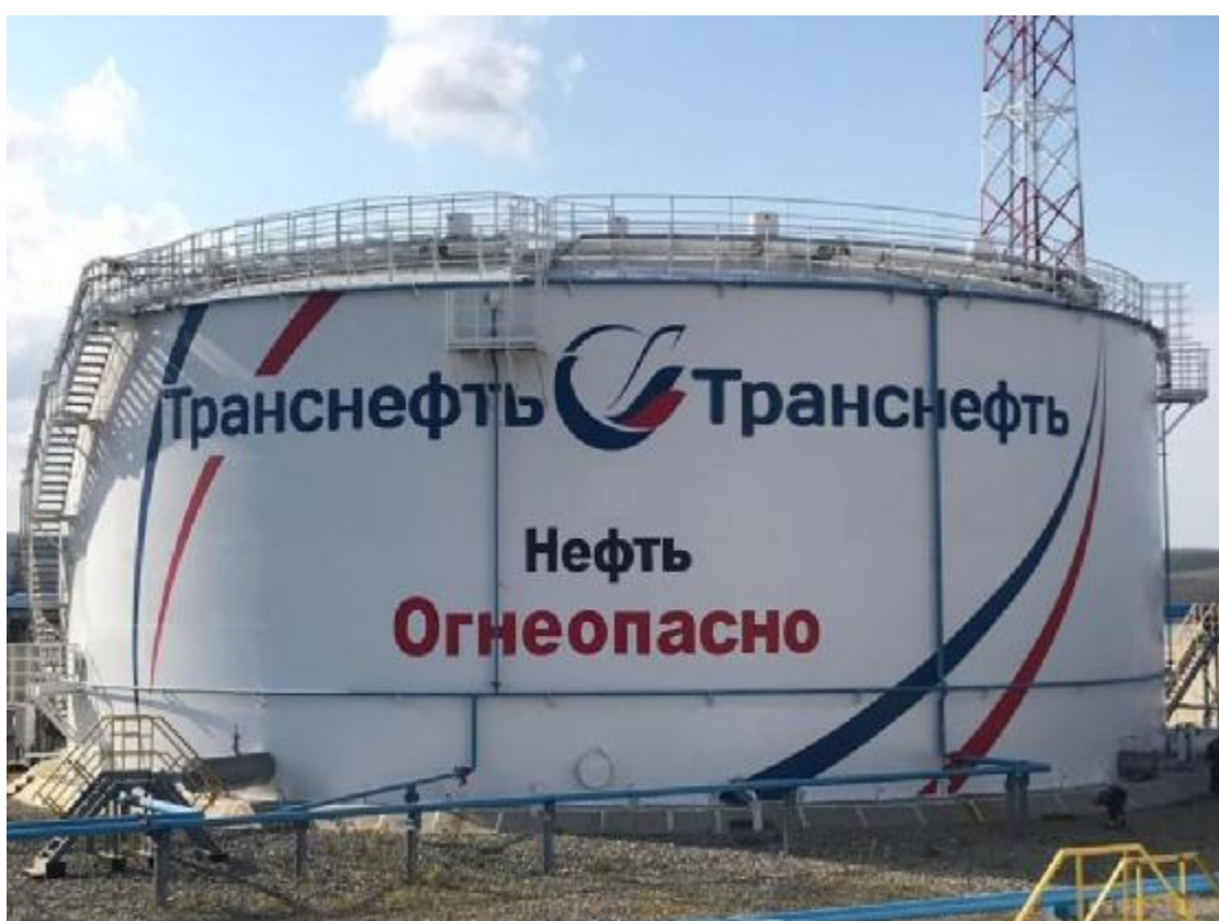
Рисунок 2 – Общий вид резервуаров РВСП-10000 зав.№№ 8, 9
