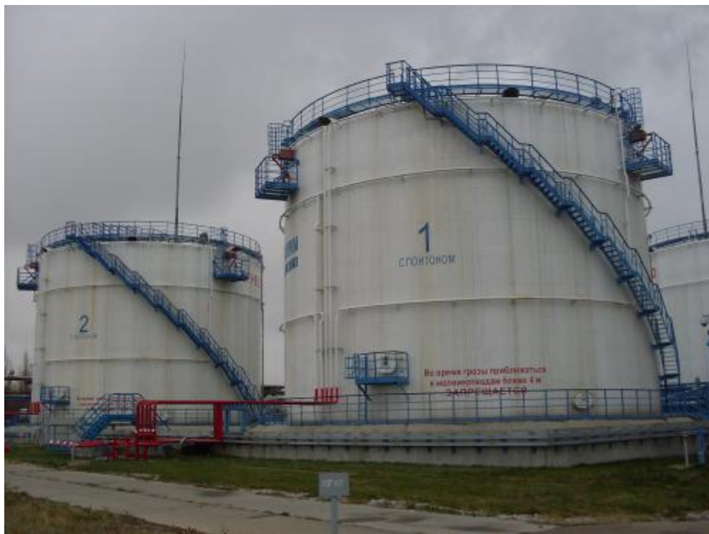
Рисунок 1 – Общий вид резервуаров стальных вертикальных цилиндрических с понтоном РВСП-5000
