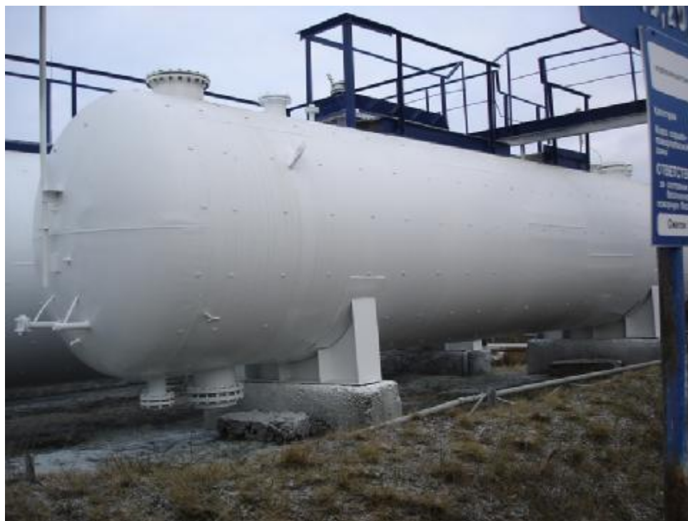
Рисунок 1 – Общий вид резервуара горизонтального стального цилиндрического РГС-50
