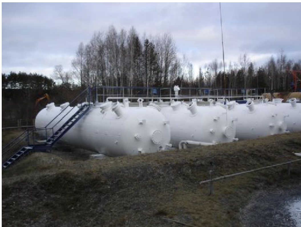
Рисунок 2 – Общий вид резервуара горизонтального стального цилиндрического РГС-75
