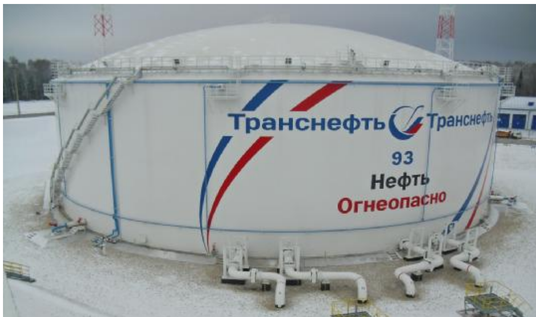
Рисунок 2 – Общий вид резервуара РВСП-50000 зав.№ 93
