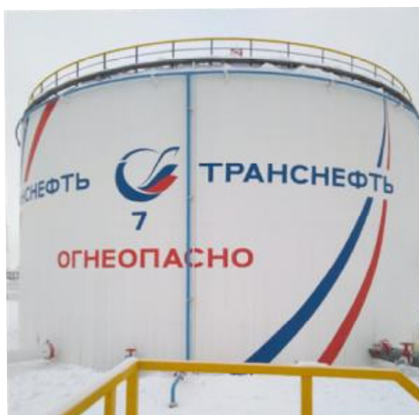
Рисунок 1 – Общий вид резервуара РВС-5000 зав.№ 7
