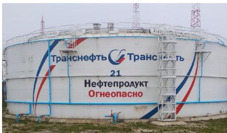
Рисунок 4 - Общий вид резервуара РВС-20000 зав.№ 21
