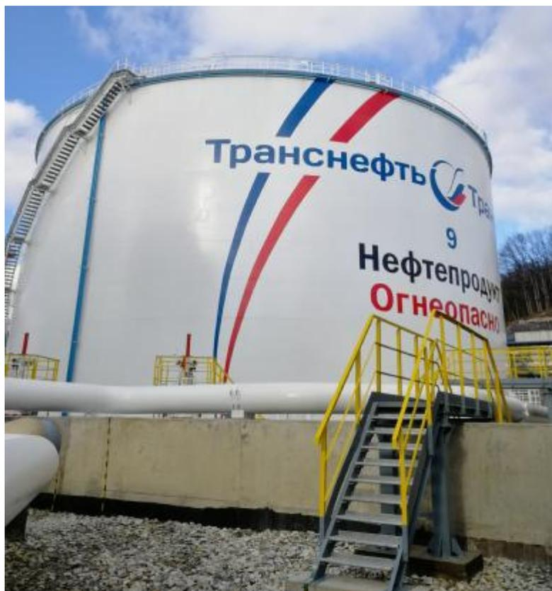
Рисунок 1 - Общий вид резервуаров стальных вертикальных цилиндрических РВС-30000
