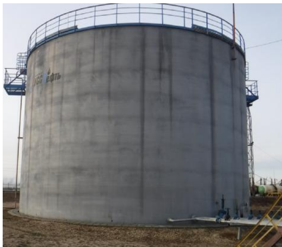
Рисунок 3 – Резервуар вертикальный стальной РВС-3000
