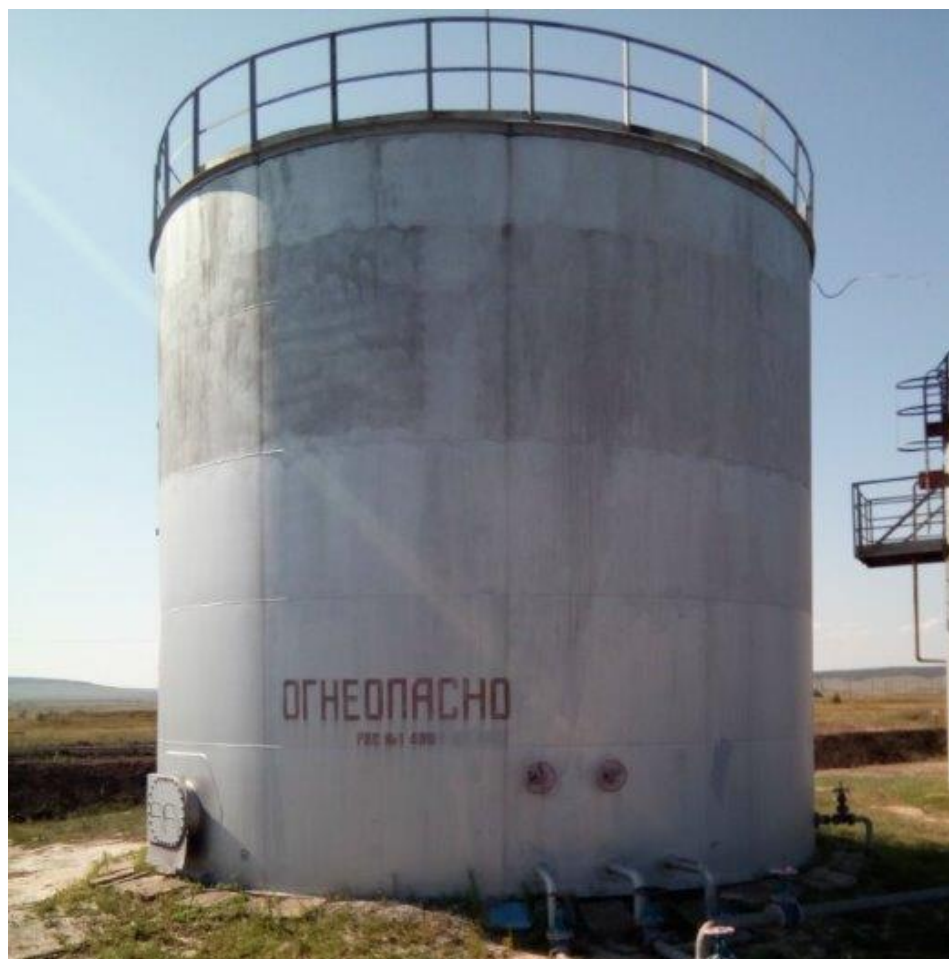
Рисунок 1 – Резервуар вертикальный стальной РВС-400
