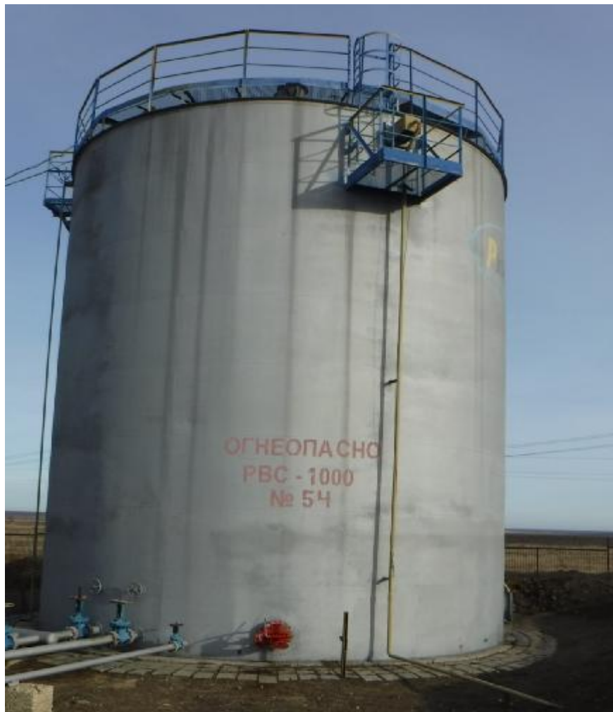
Рисунок 1 – Резервуар вертикальный стальной РВС-1000
