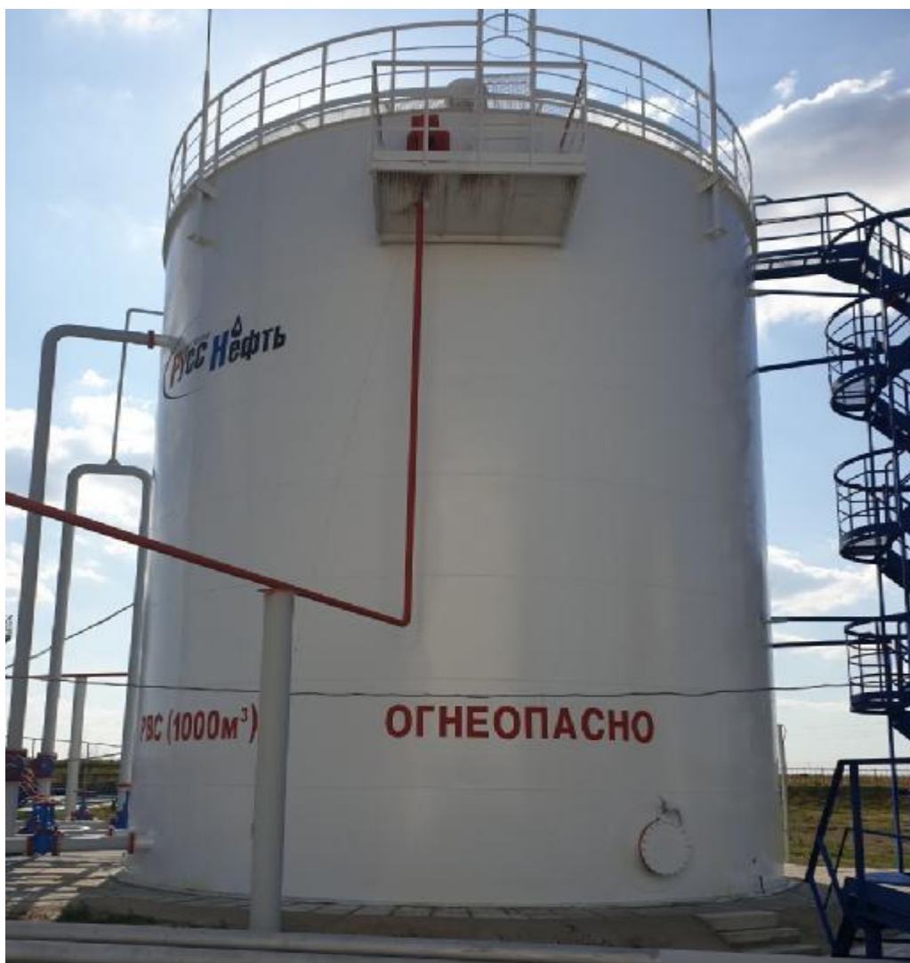
Рисунок 1 – Резервуар вертикальный стальной РВС-1000
