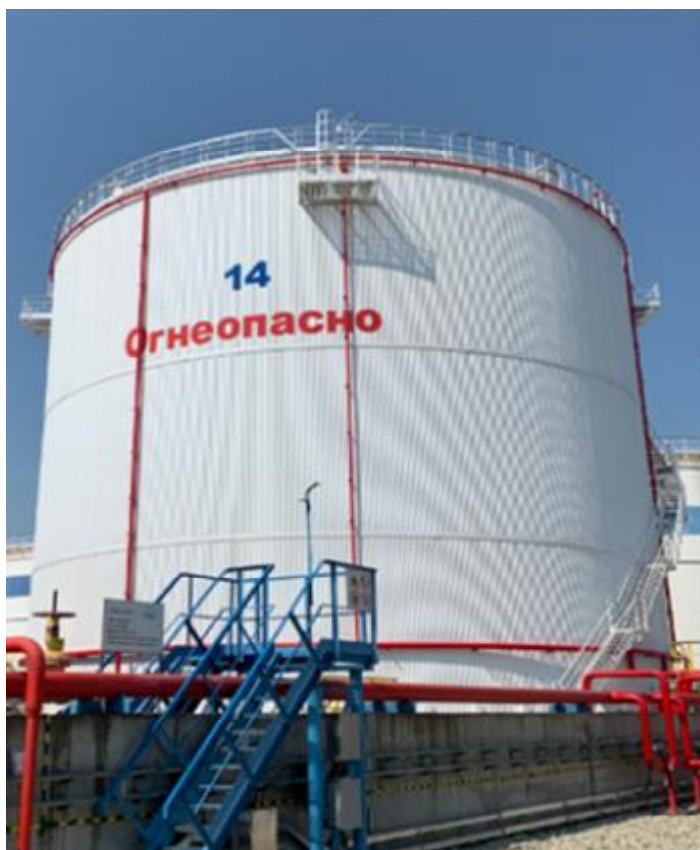
Рисунок 1 – Общий вид резервуара стального вертикального цилиндрического теплоизолированного РВС-15000
