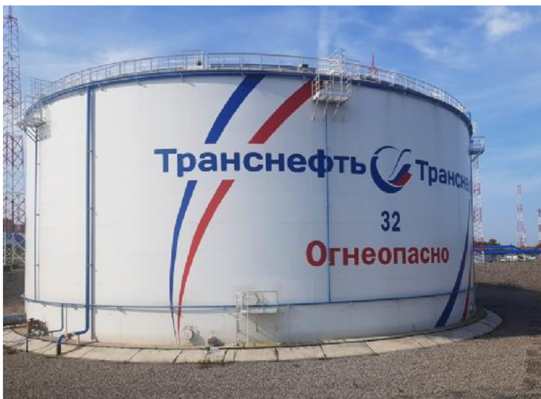
Рисунок 2 – Общий вид резервуара РВСП-30000 зав.№ 32
