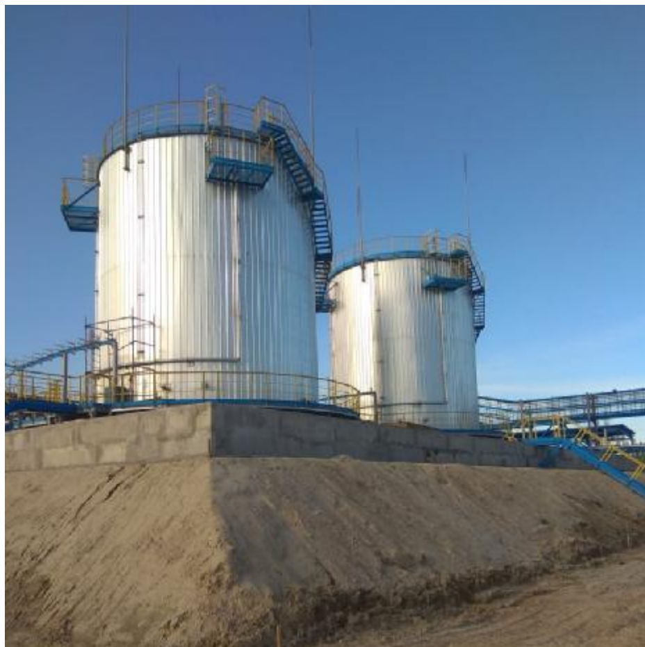
Рисунок 1 – Общий вид резервуаров РВС-1000
