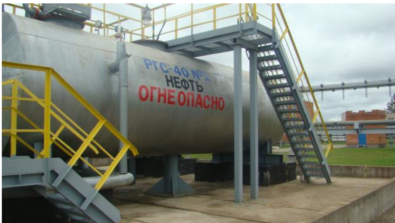
Рисунок 1 – Общий вид резервуара РГС-40
