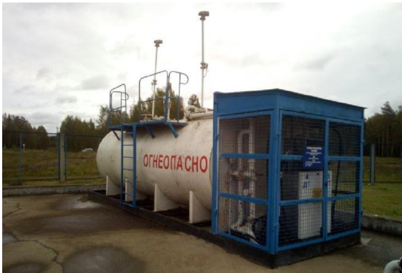
Рисунок 1 – Общий вид резервуара РГС-20
