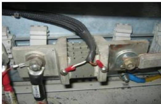
Рисунок 8 – Шунт измерительный
