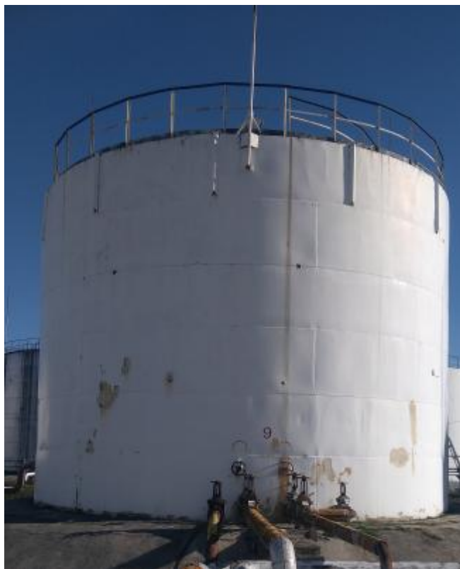
Рисунок 1 – Общий вид резервуара стального вертикального цилиндрического РВС-1000
