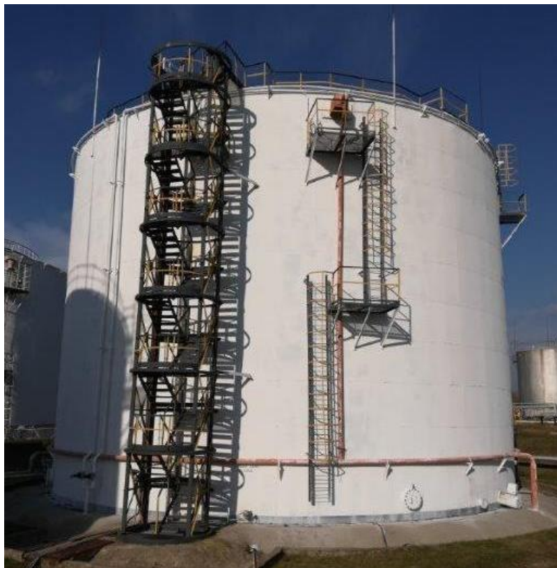
Рисунок 4 – Общий вид резервуара стального вертикального цилиндрического РВСП-5000
