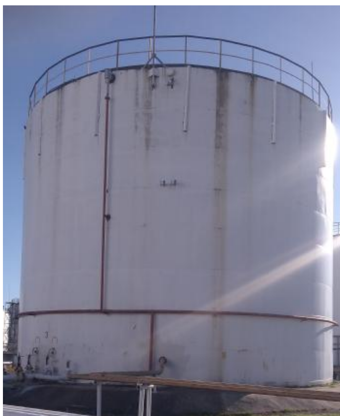
Рисунок 3 – Общий вид резервуара стального вертикального цилиндрического РВСП-2000
