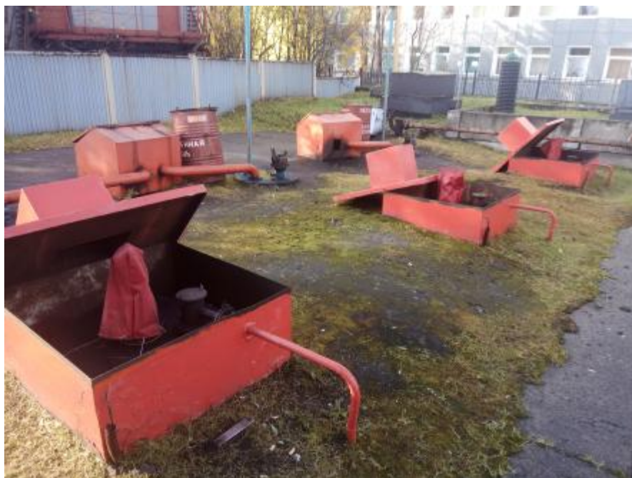
Рисунок 2 – Общий вид видимой части конструкции резервуаров РГС-25 с зав. №№ 1, 2, 3
