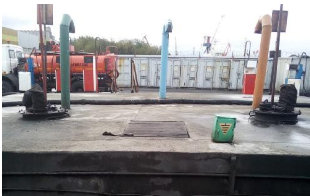
Рисунок 3 – Общий вид видимой части конструкции резервуаров РГС-25 с зав. №№ 844, 875
