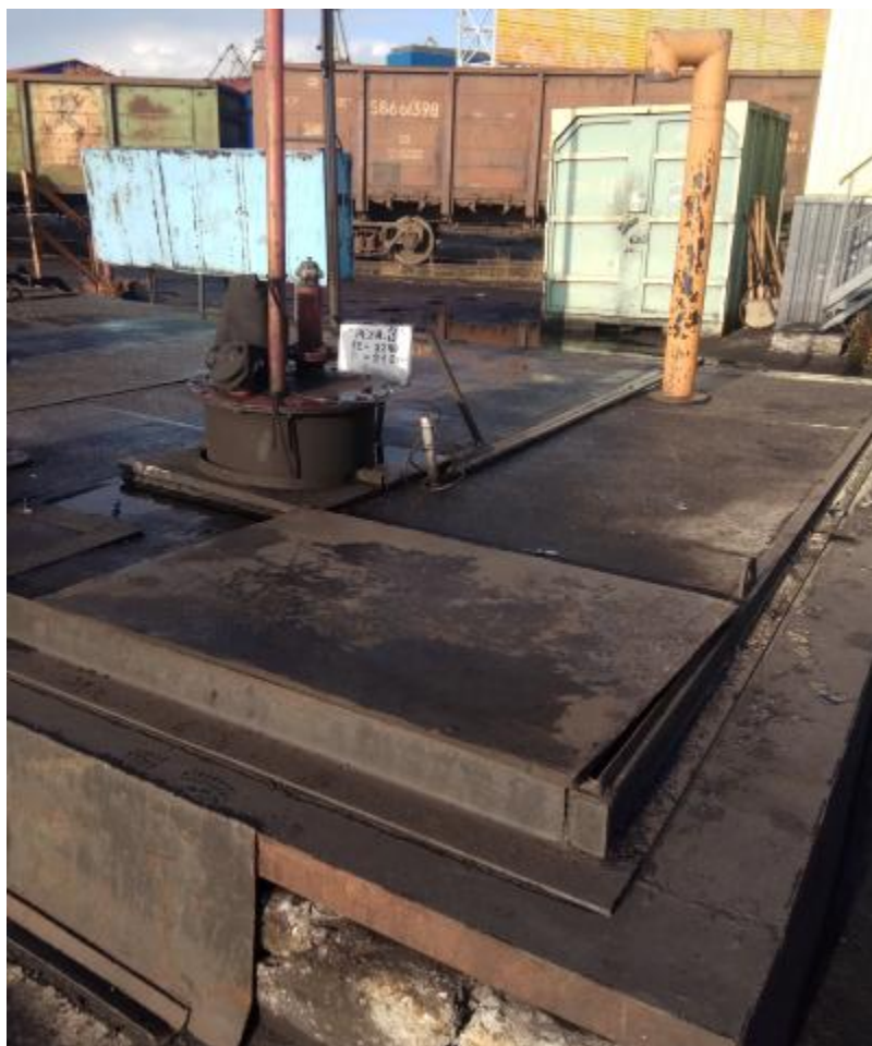
Рисунок 1 – Общий вид видимой части конструкции резервуара РГС-10 с зав. № 1370
