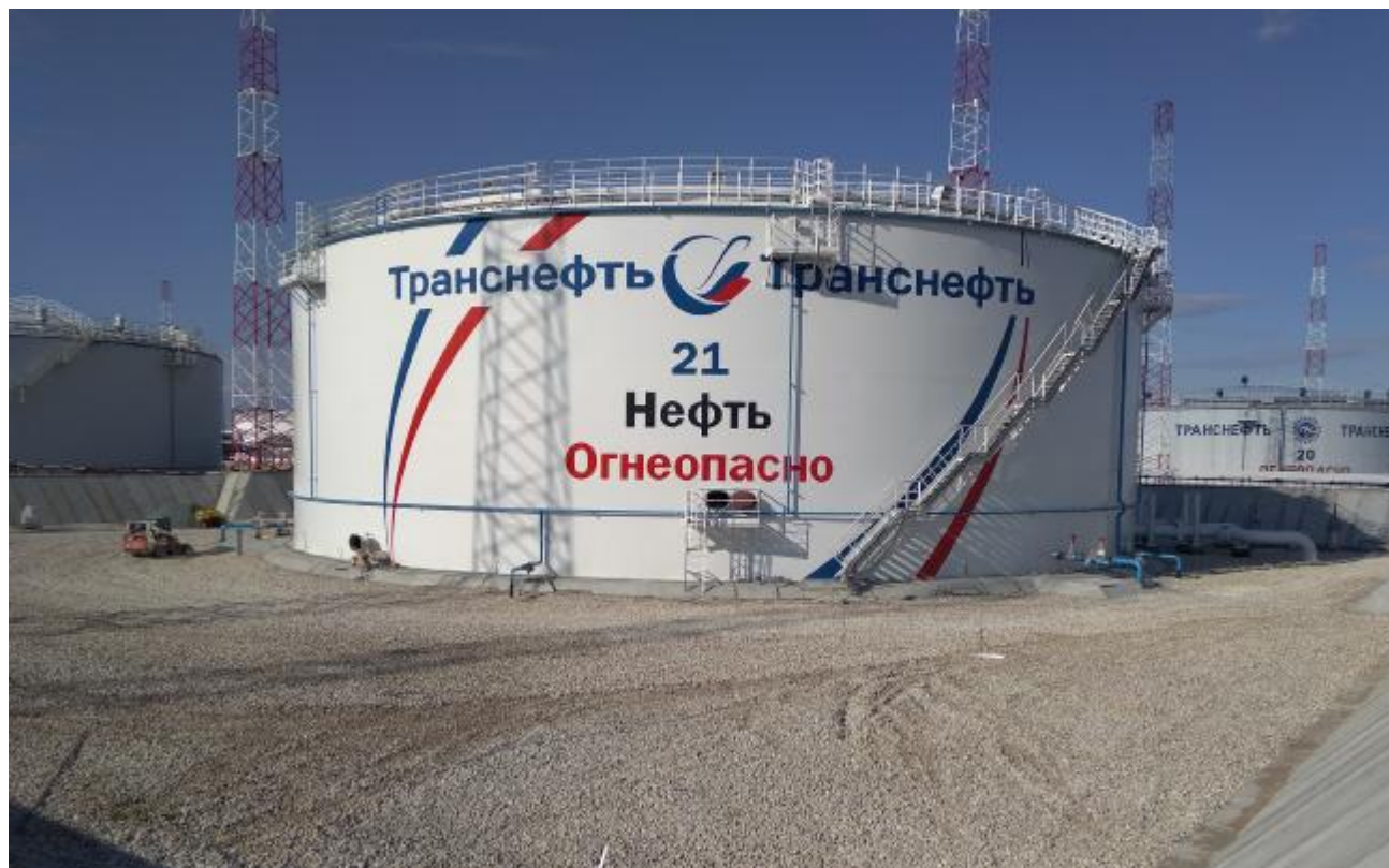
Рисунок 1 – Общий вид резервуара РВСП-20000
