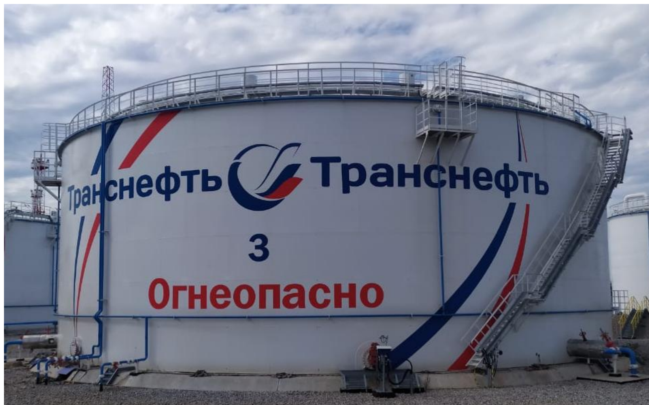
Рисунок 1 – Общий вид резервуара РВСП-10000
