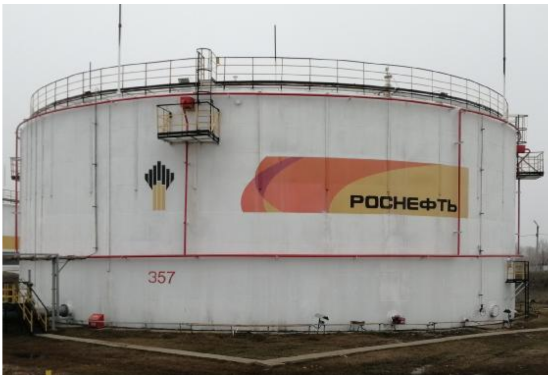
Рисунок 2 – Общий вид резервуара стального вертикального цилиндрического РВС-10000
