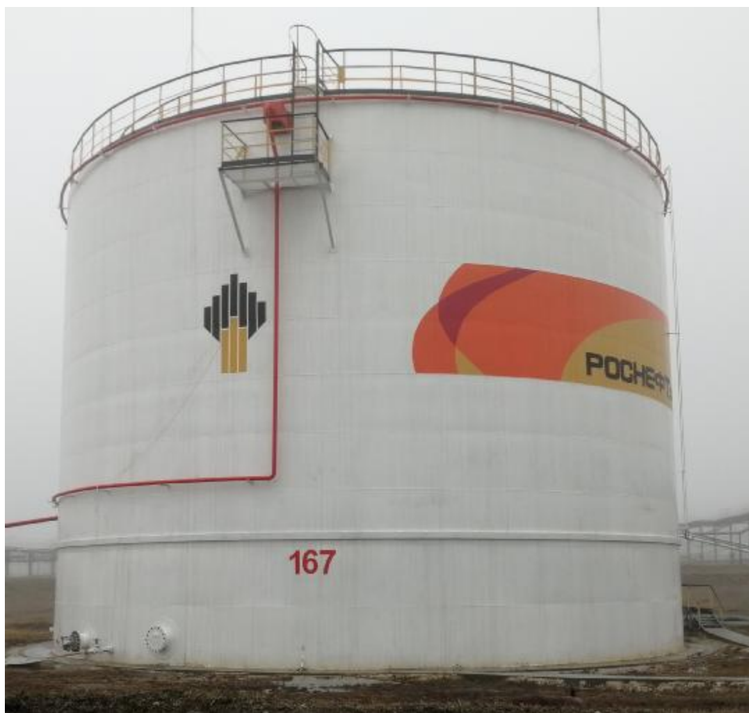
Рисунок 1 – Общий вид резервуара стального вертикального цилиндрического РВС-5000
