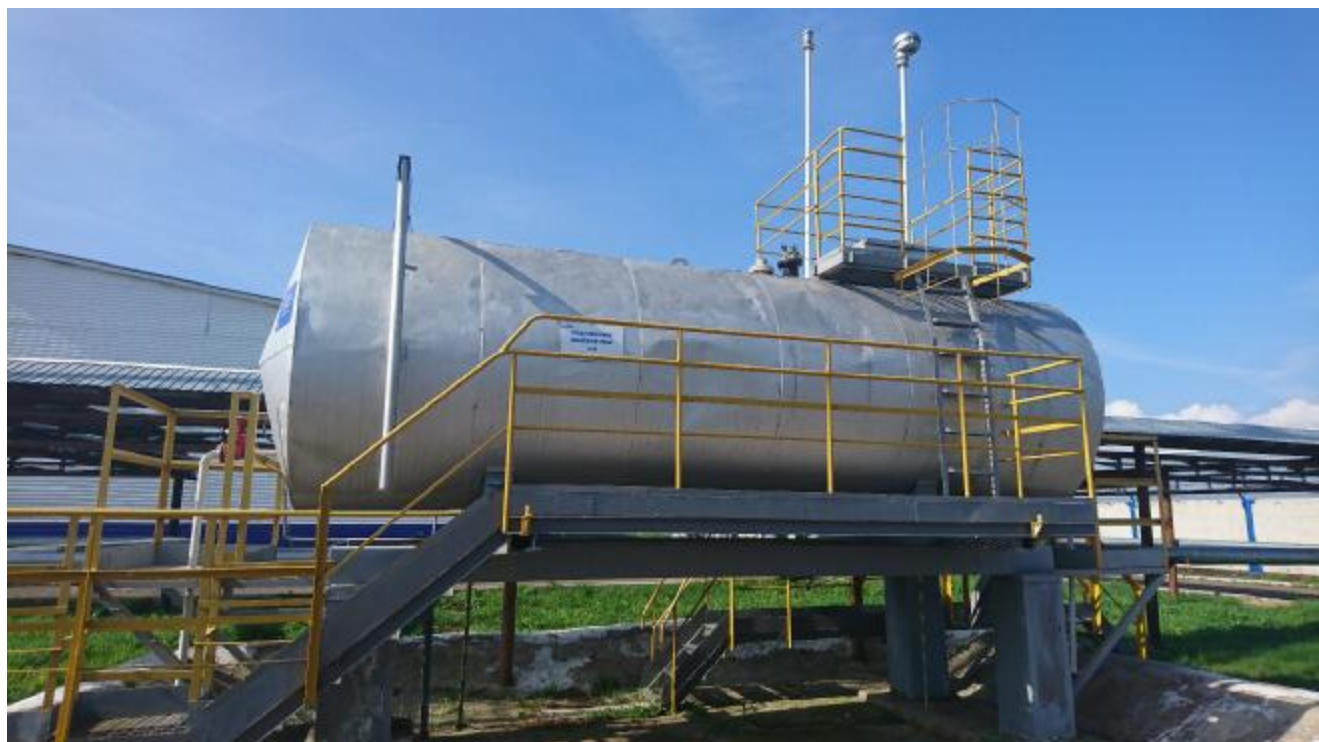
Рисунок 1 – Общий вид резервуара стального горизонтального цилиндрического РГС-20
