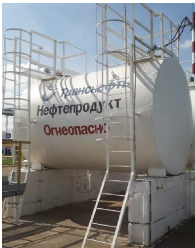
Рисунок 1 – Общий вид резервуара РГС-25
