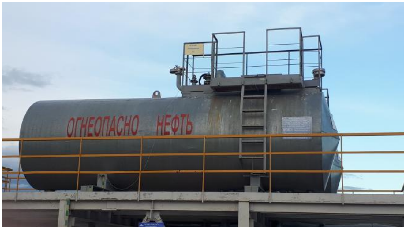
Рисунок 1 – Общий вид резервуара РГС-20
