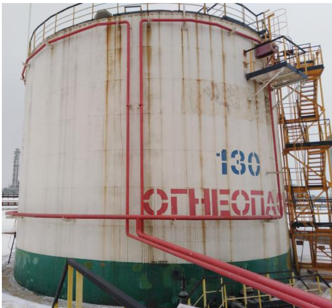
Рисунок 1 – Общий вид резервуара стального вертикального цилиндрического РВСП-2000
