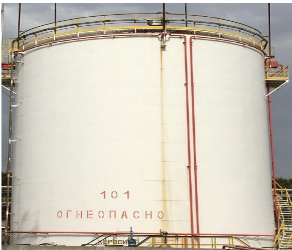
Рисунок 1 – Общий вид резервуара стального вертикального цилиндрического РВС-3000
