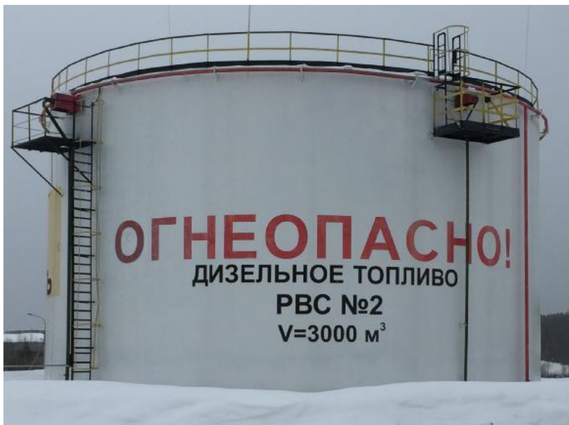
Рисунок 1 – Общий вид резервуара стального вертикального цилиндрического РВС-3000
