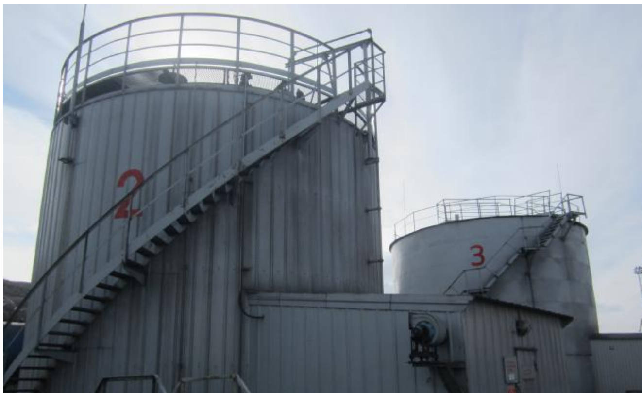
Рисунок 1 – Общий вид резервуаров
