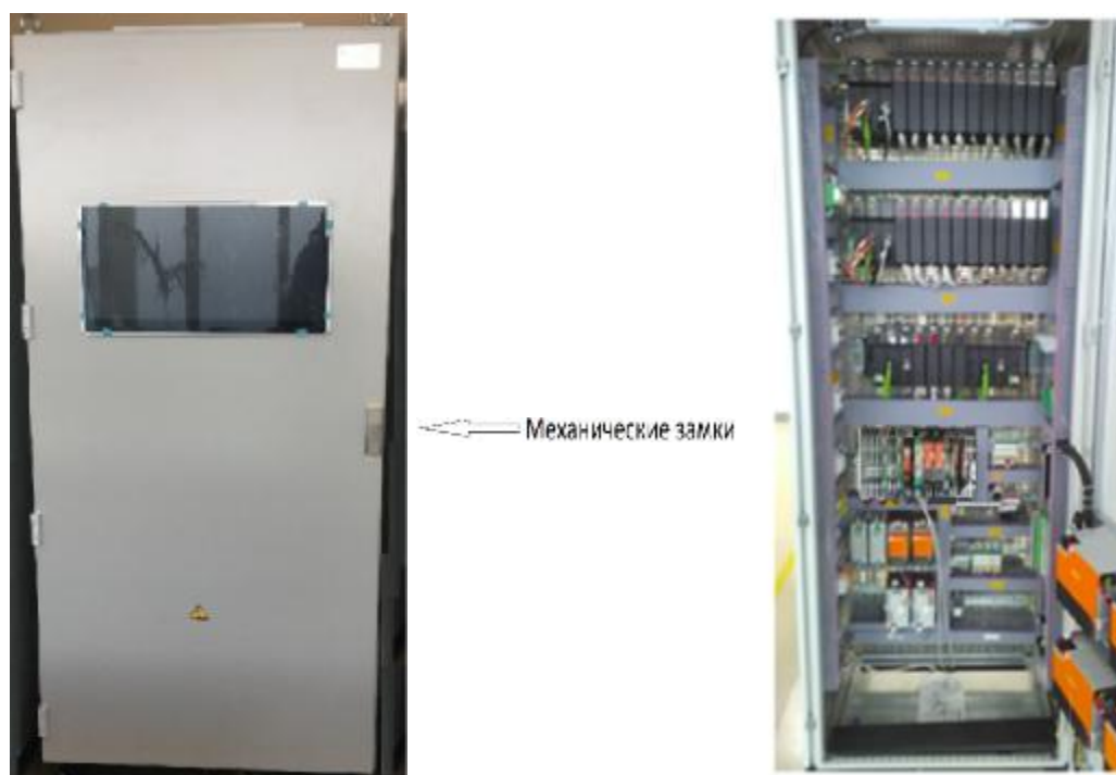
Рисунок 1 - Общий вид шкафа ПТК
