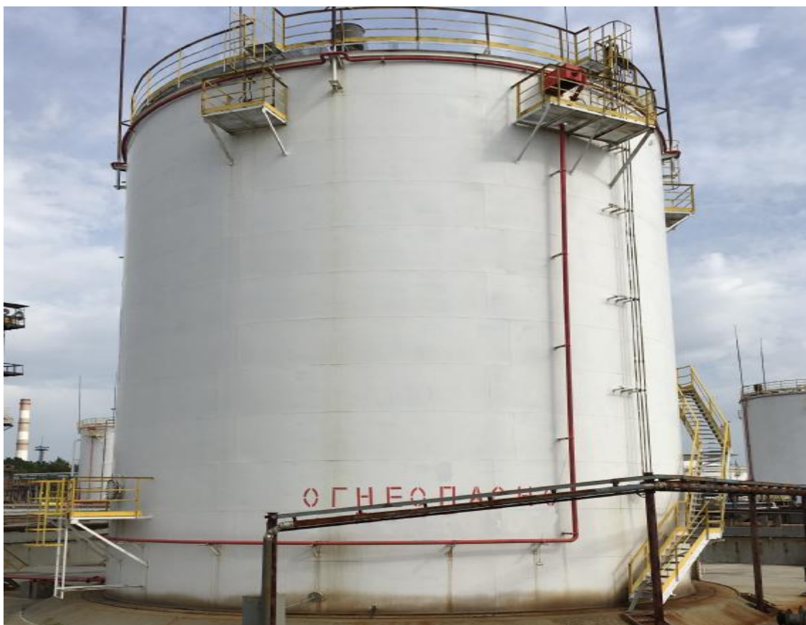
Рисунок 1 – Общий вид резервуара стального вертикального цилиндрического РВСП-3000
