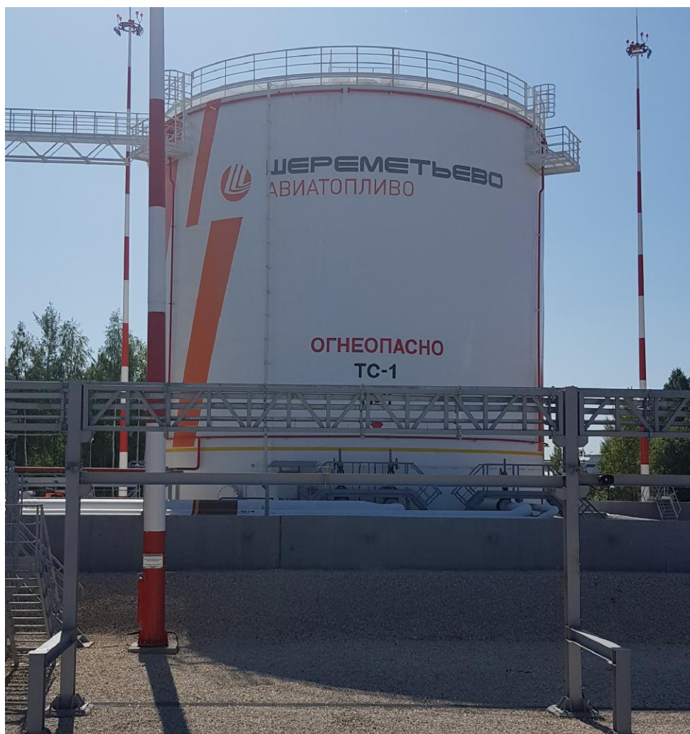
Рисунок 1 – Общий вид резервуаров РВС-5000
