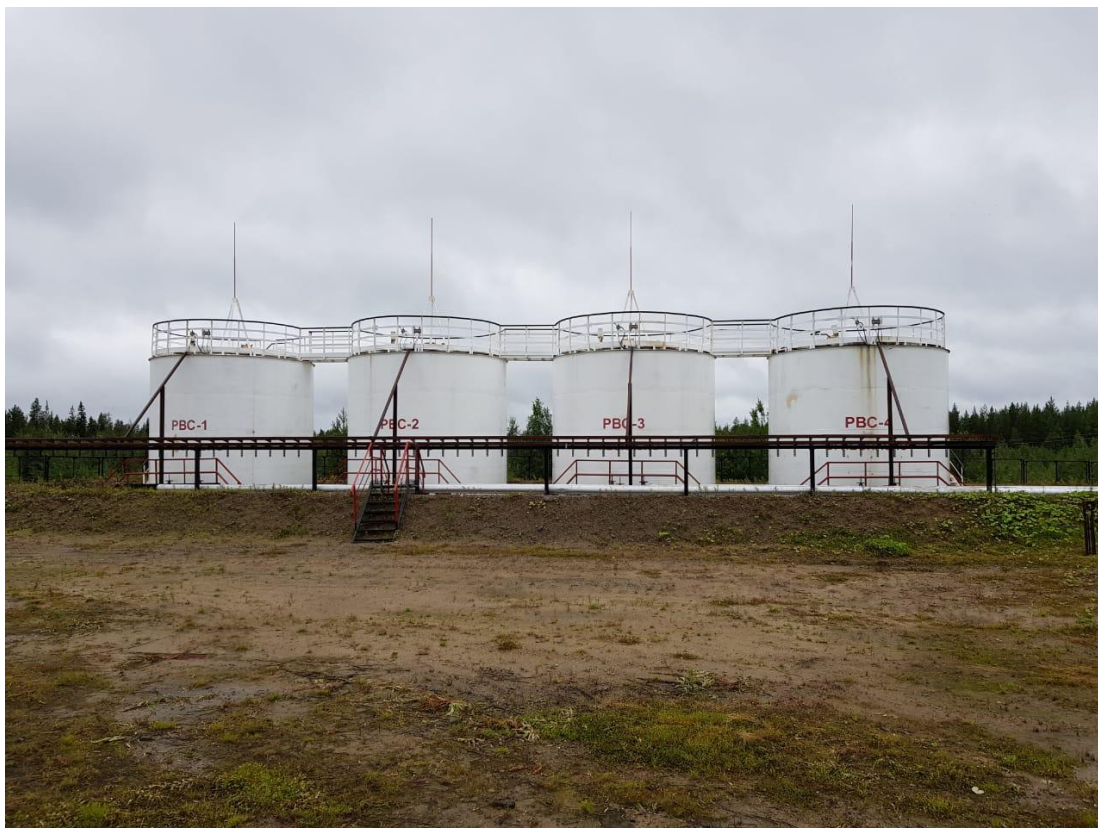
Рисунок 1 – Общий вид резервуаров стальных вертикальных цилиндрических РВС-200
