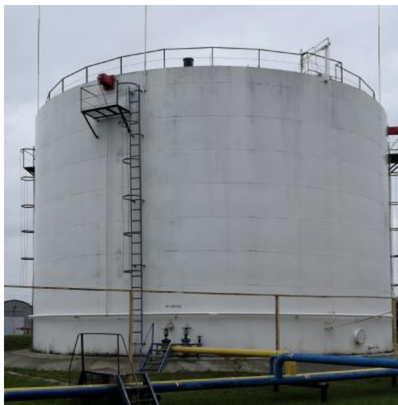
Рисунок 3 – Общий вид резервуара вертикального стального цилиндрического РВС-3000
