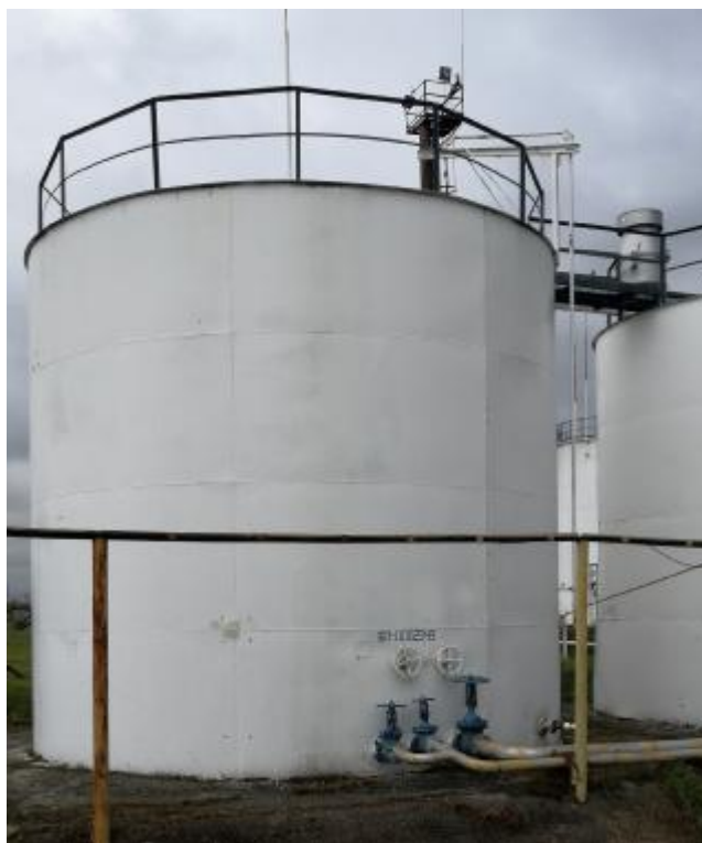
Рисунок 1 – Общий вид резервуара вертикального стального цилиндрического РВС-200,
