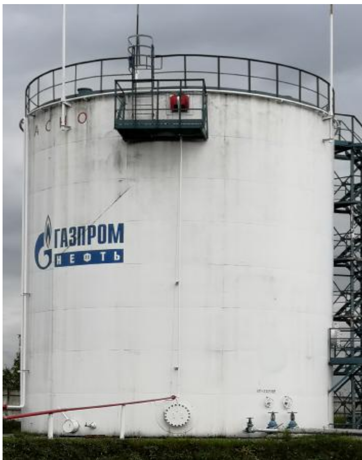
Рисунок 2 – Общий вид резервуара вертикального стального цилиндрического РВС-1000
