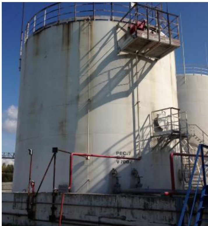
Рисунок 1 – Общий вид резервуара вертикального стального цилиндрического РВС-700
