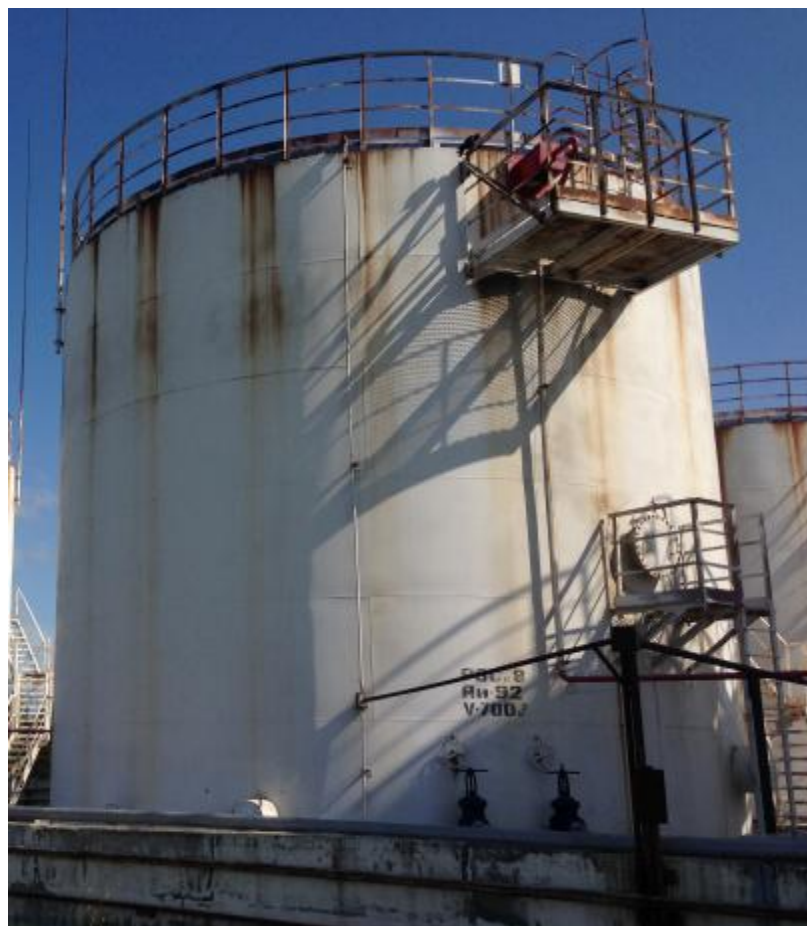
Рисунок 2 – Общий вид резервуара вертикального стального цилиндрического РВСП-700
