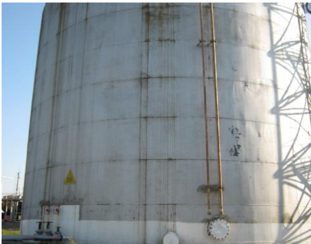
Рисунок 4 – Общий вид резервуара стального вертикального цилиндрического РВС-2000
