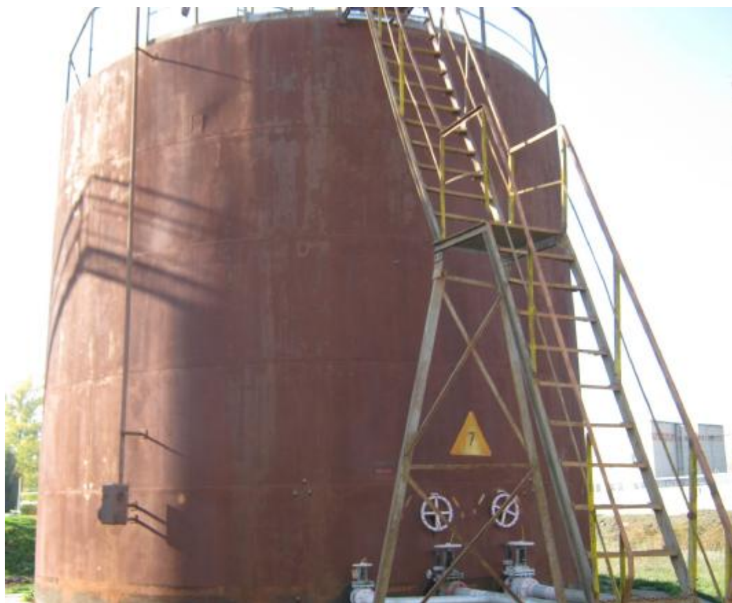
Рисунок 1 – Общий вид резервуара стального вертикального цилиндрического РВС-400
