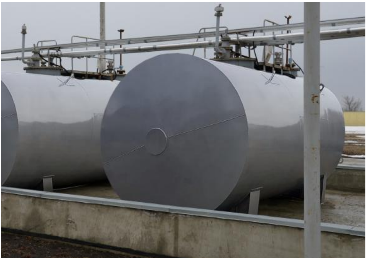
Рисунок 1 – Резервуар стальной горизонтальный цилиндрический двустенный РГС-25
