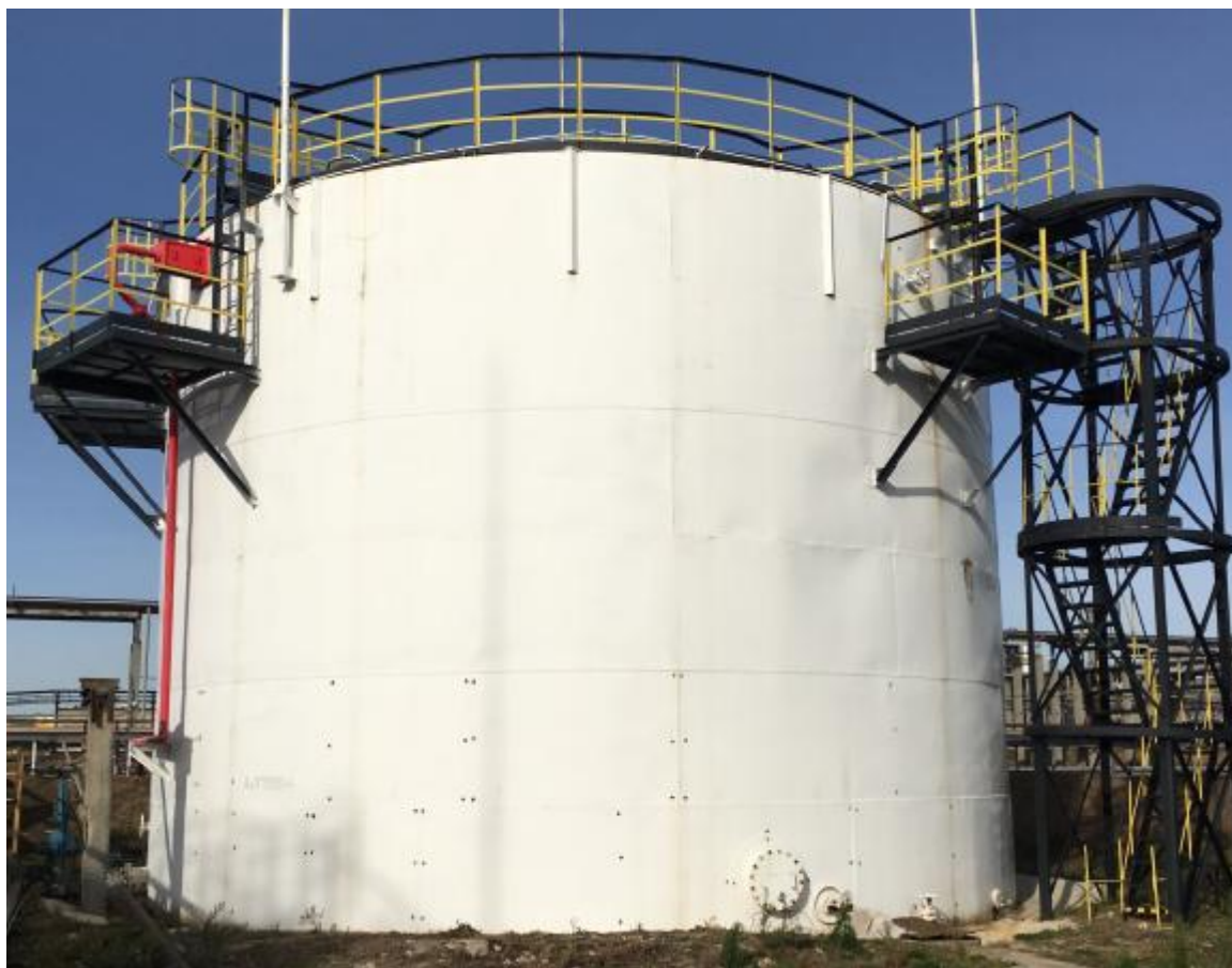
Рисунок 2 – Общий вид резервуара стального вертикального цилиндрического РВСП-1000
