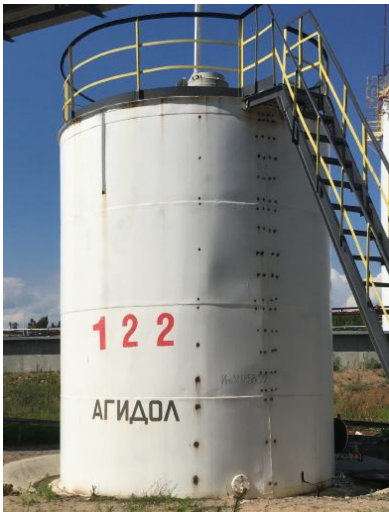
Рисунок 1 – Общий вид резервуара стального вертикального цилиндрического РВС-100
