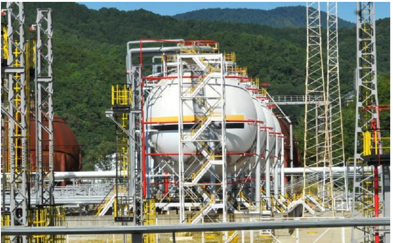
Рисунок 1 - Общий вид резервуаров
