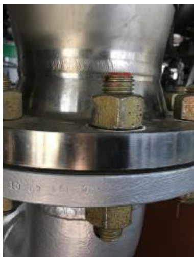
Рисунок 1 – Схема пломбировки массомера
