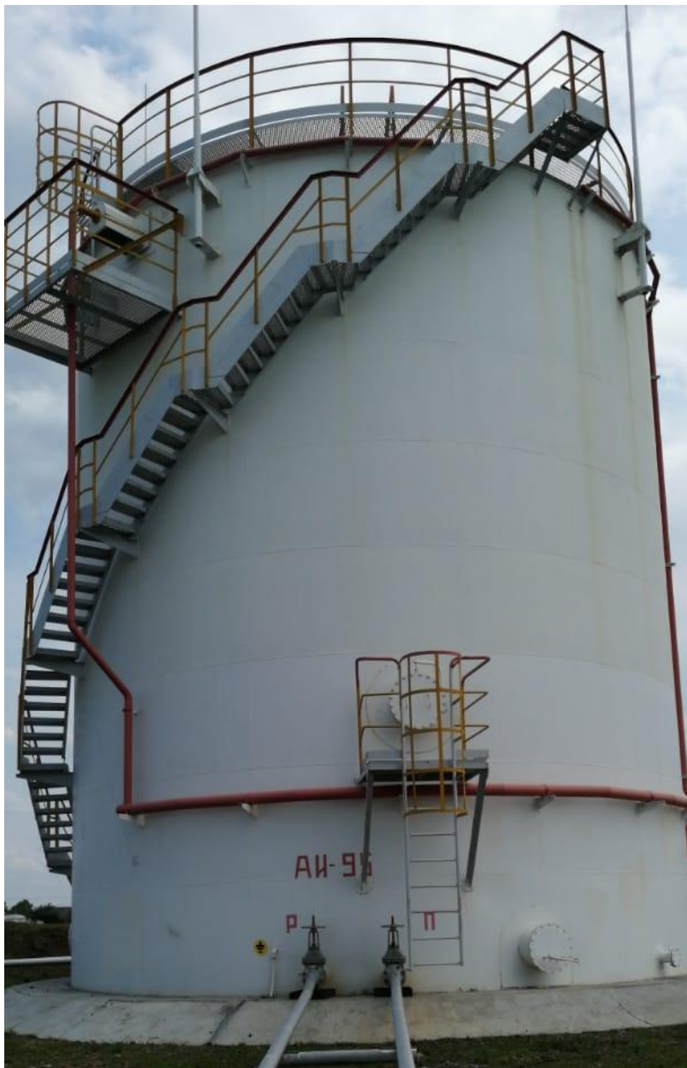
Рисунок 1 – Общий вид резервуара стального вертикального цилиндрического РВСП-1000
