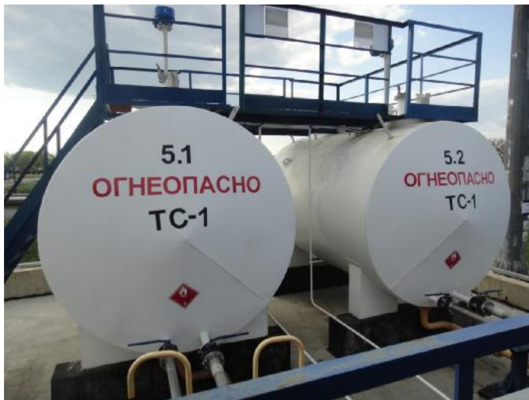
Рисунок 1 – Общий вид резервуаров горизонтальных стальных цилиндрических РГС-25
