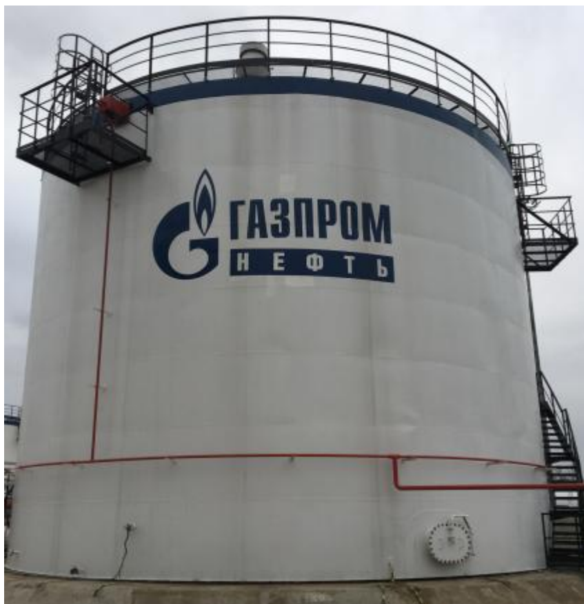
Рисунок 2 – Общий вид резервуаров стальных вертикальных цилиндрических РВС-2000
