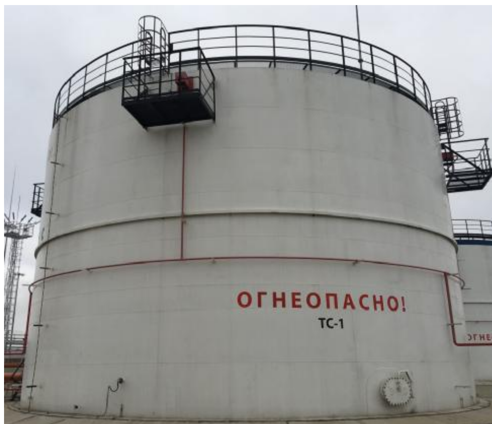
Рисунок 1 – Общий вид резервуаров стальных вертикальных цилиндрических РВС-3000
