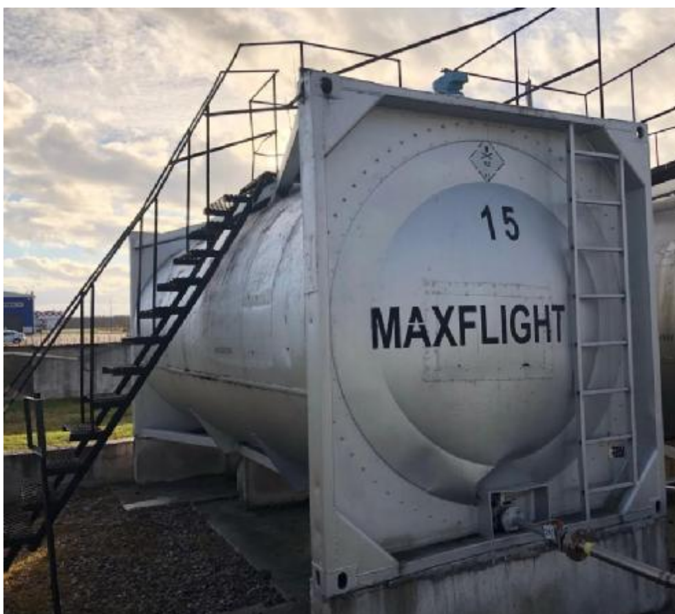
Рисунок 1 – Общий вид резервуаров РГС-25
