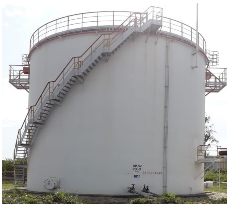
Рисунок 2 – Общий вид резервуара стального вертикального цилиндрического РВСП-2000
