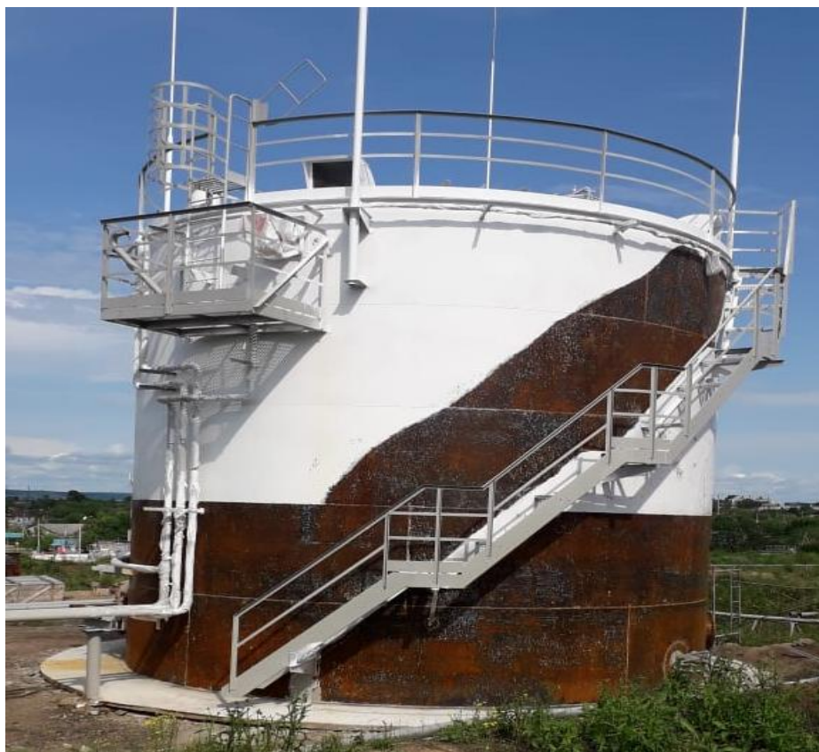
Рисунок 1 – Общий вид резервуара стального вертикального цилиндрического РВСП-400
