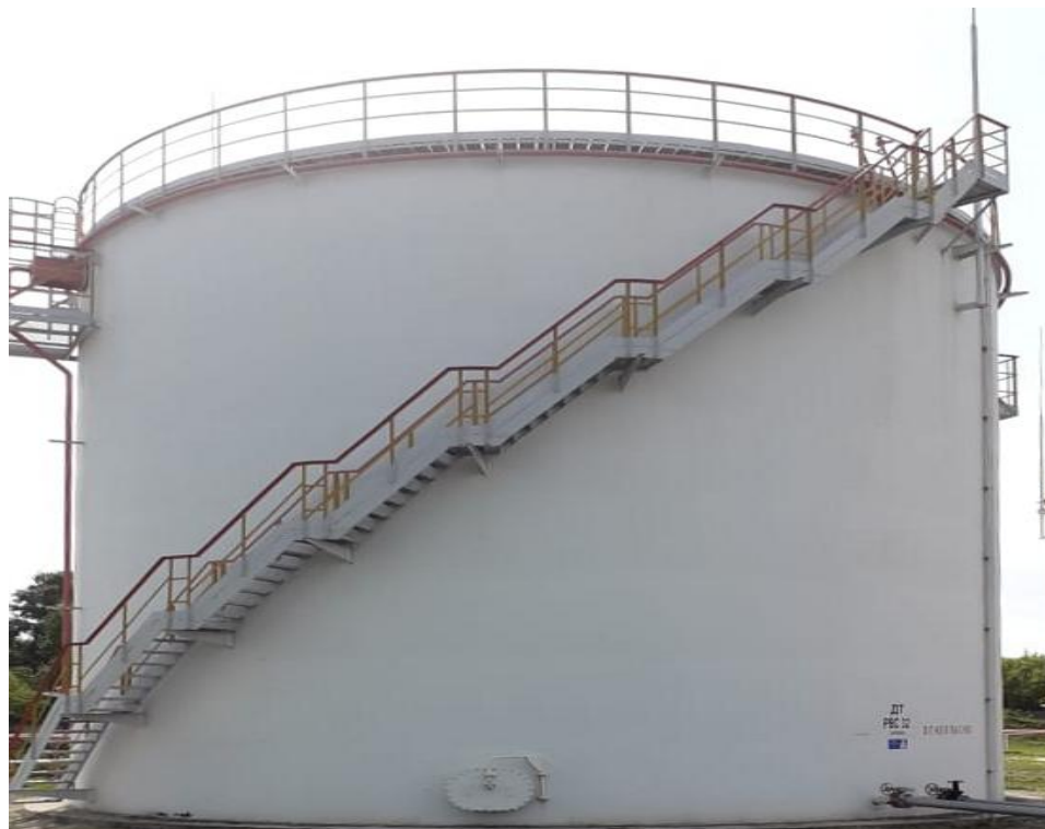
Рисунок 3 – Общий вид резервуара стального вертикального цилиндрического РВС-2000
