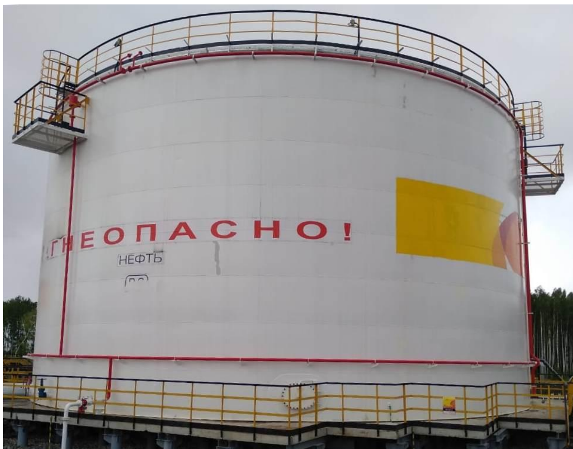
Рисунок 1 – Общий вид резервуара стального вертикального цилиндрического РВС-5000
