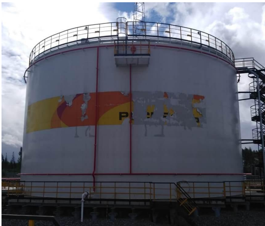
Рисунок 1 – Общий вид резервуара стального вертикального цилиндрического РВС-5000
